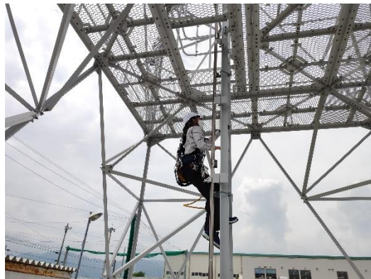
モバイルアンテナの 施工現場で
