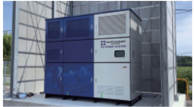
定置式FC発電機（純水素燃料電池）
