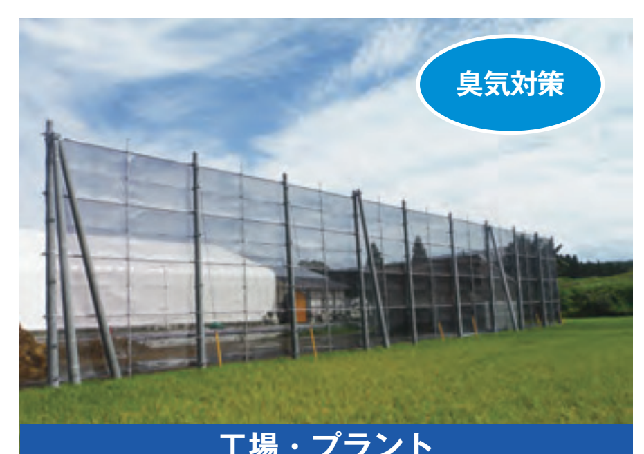
工場・プラント
